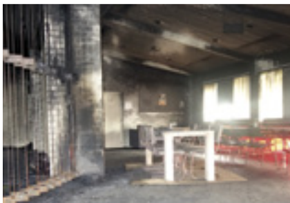
Van de schuifwand (links) was alleen nog het metalen skelet over.
